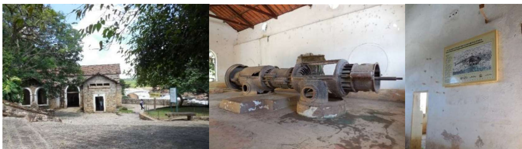
FIGURA 4 - Casa de máquinas da PCH das Lavras
